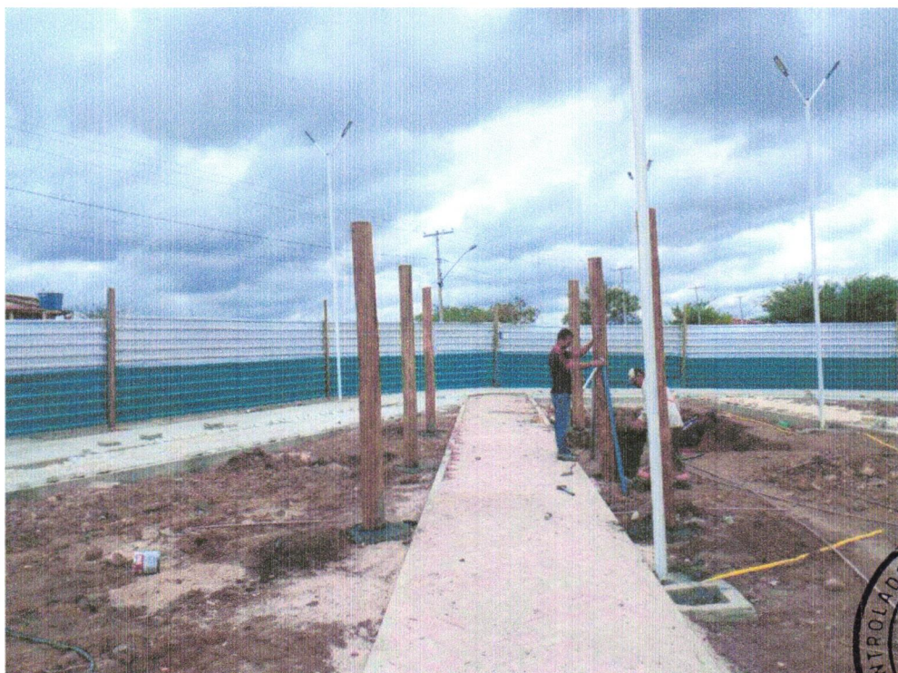
Foto 14 - CONCRETO MAGRO, APLICADO EM BLOCOS DE COROAMENTO OU SAPATAS. AF_08/2017
