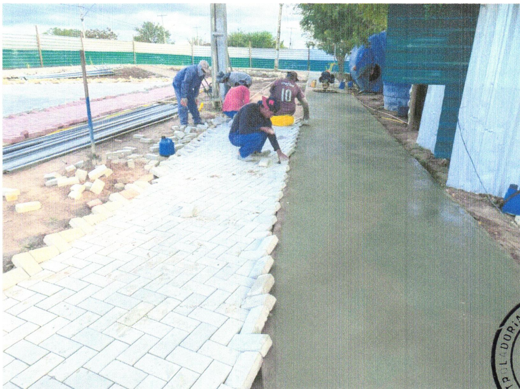
Foto 02 – EXECUÇÃO DE PASSEIO EM PISO INTERTRAVADO, COM BLOCO RETANGULAR COR NATURAL DE 20 X 10 CM, ESPESSURA 6 CM. AF_12/2015
