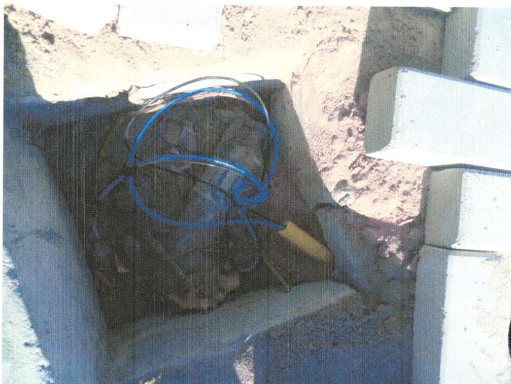
Foto 12 - CABO DE COBRE FLEXÍVEL ISOLADO, 2,5 MM 2 , ANTI-CHAMA 0,6/1,0 KV, PARA CIRCUITOS TERMINAIS - FORNECIMENTO E INSTALAÇÃO. AF_12/2015
