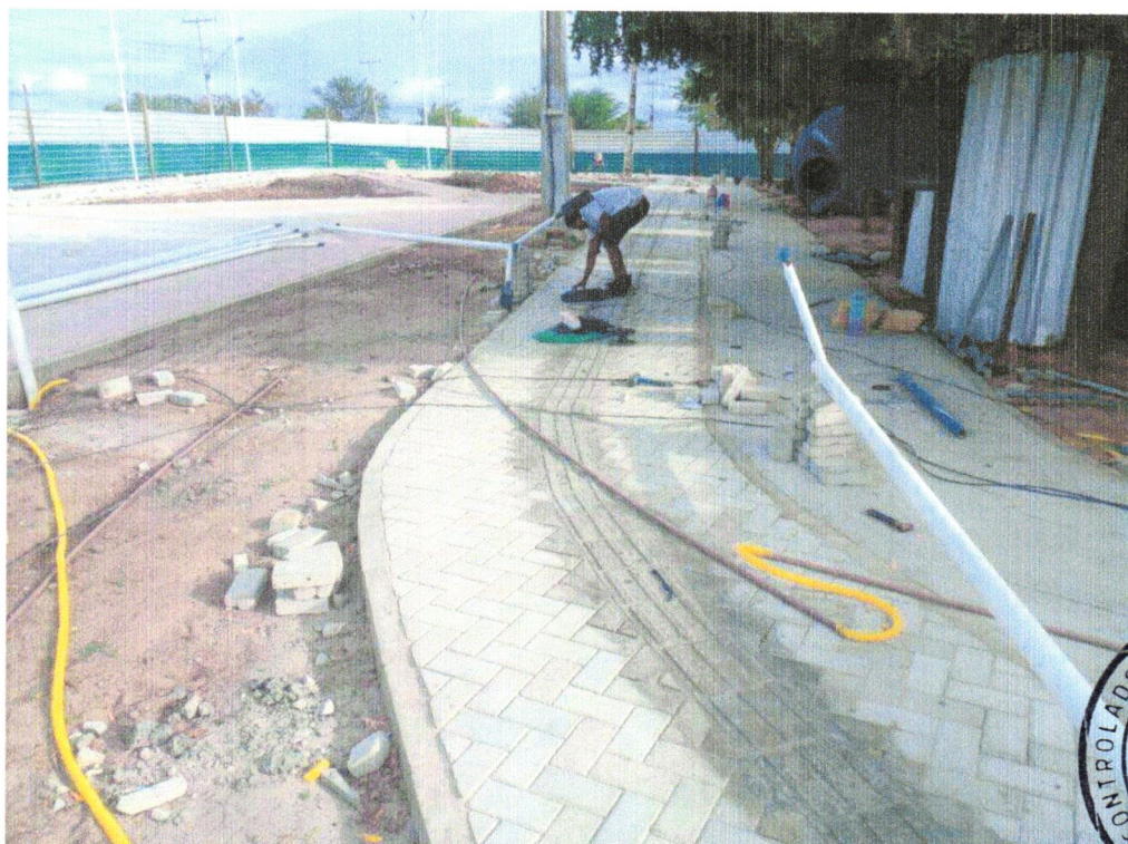
Foto 04 - Piso tátil direcional e/ou alerta, de concreto, colorido, p/deficientes visuais, dimensões 25x25cm, aplicado com argamassa industrializada ac-ii, rejuntado, exclusive regularização de base
